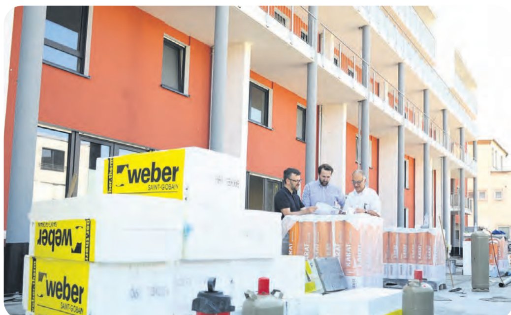
Für die Erdgeschoss- und Familien-Maisonette-Wohnungen entstehen über dem Parkdeck im Untergeschoss kleine, private Gärten mitten in der Stadt. Oben sind die Balkone an der Gebäuderückseite zu sehen.
