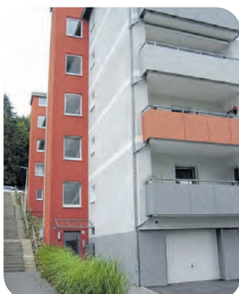
„Auf dem Winkel“ haben die IGW-Häuser Aufzüge erhalten.
