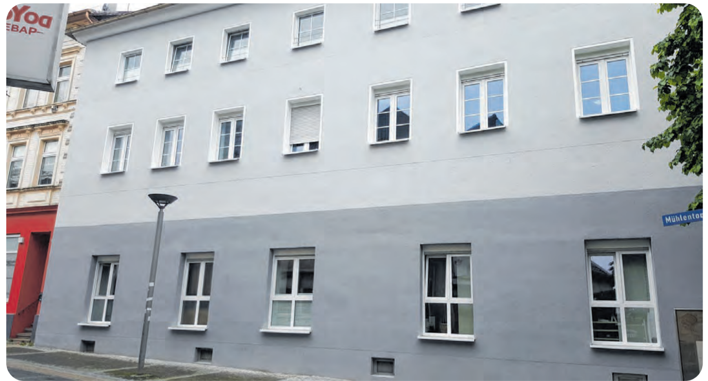
So sieht das Haus Mühlentor 13 heute aus, nachdem die IGW das Gebäude in Zusammenarbeit mit dem Verein „Wohnprojekt 170 Grad“ und der Diakonie modernisiert und an die Wohnbedürfnisse junger Menschen mit Behinderung angepasst hat.
