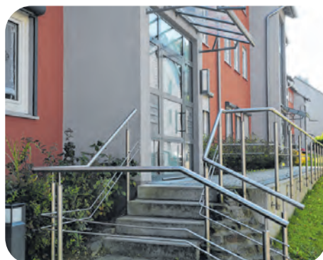
Die lange Rampe sorgt für die barrierearme Zufahrt zur Wohnung der Eheleute Schulz.
