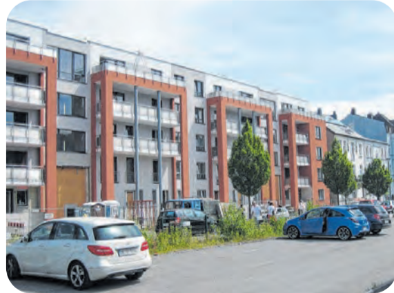
Das jüngste IGW-Neubauprojekt an der Rahmenstraße.
