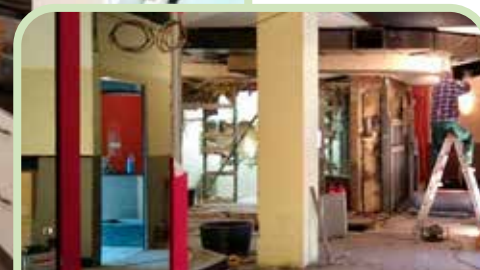
Umbaumaßnahmen Am Mühlentor 13 (EG)
